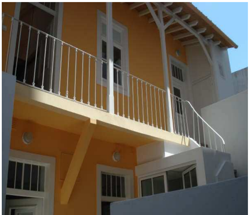
Depois da Obra
